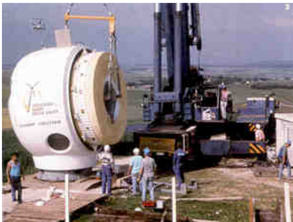
Figure 3-6. Jeumont 750 kW (nacelle)
